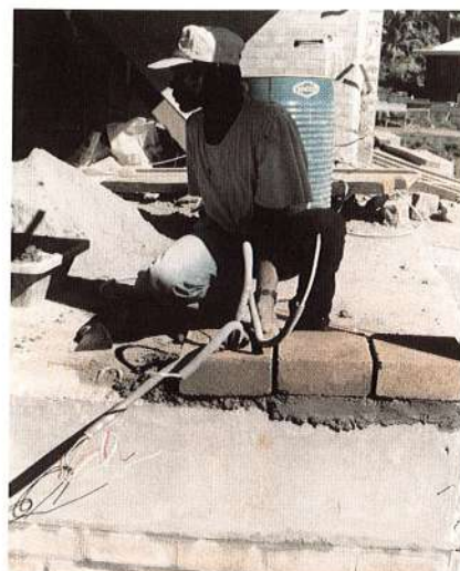
Ci-dessus : Mise en œuvre d'un mur en BTC de 22 x 22 avec passage des gaines électriques. Chaque BTC est taillé en l'absence de blocs avec réservation spécialement conçue pour ce détail.
