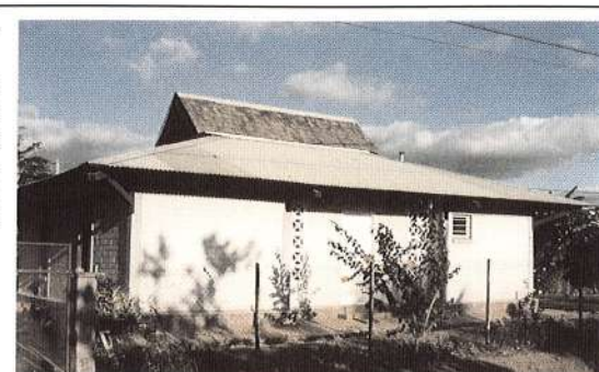
Façade sur l'entrée
