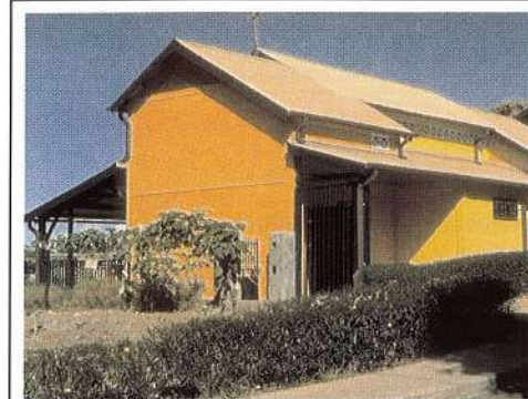
PASSAMAINTY, conception et réalisation SIM logement locatif proche du modèle case évolutive urbaine de l'habitat social.
