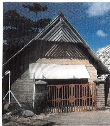
Buvette Al Pa Joe. Mamoudzou. Réalisation SIM, 1986. Ce projet est surtout attrayant pour la superbe charpente réalisée par des compagnons charpentiers, mais on peut toutefois relever l'appareillage soigné des angles à 45°.
