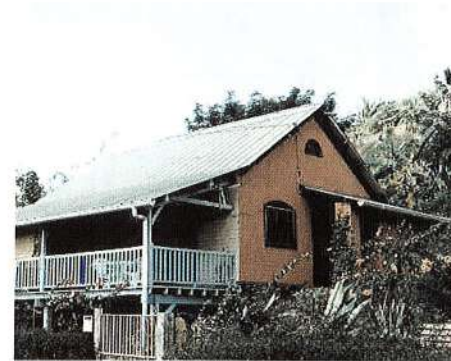
Conception et réalisation SIM, 1983. Logement Locatif Modèle T3. Ces modèles simples possèdent des varangues spacieuses, de larges débords de toiture et des aménagements de cunettes qui se sont avérés des protections efficaces du bâtiment dans le temps.
