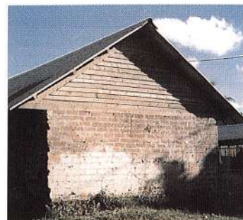
Ci-dessus: MAGASIN SIM, petite terre. Illustration d'une maçonnerie en forme de boîte, autostable et autoporteuse, puisque ici la toiture est portée par une ossature bois à l'intérieur du bâtiment
