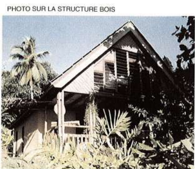
PHOTO SUR LA STRUCTURE BOIS
