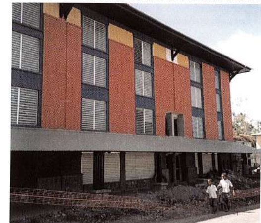
Construction en maçonnerie porteuse de BTC de 22 x 22 cm
