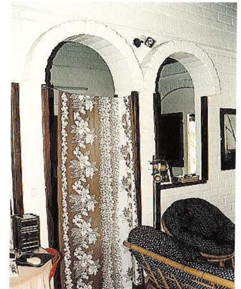
Conception et réalisation SIM, 1983. Logement Locatif Modèle T4A. Vue intérieure : Des piliers maçonnés en 29,5 de part et d'autre de l'ouverture reprennent la descente de charge des arcs.
