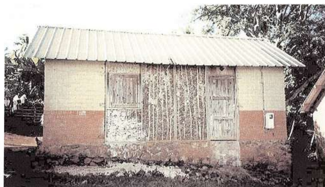
Vue extérieure d'une case. Les finitions sont réalisées par le propriétaire : ici, remplissage de l'ossature bois recouverte d'un grillage par un blocage de cailloux
