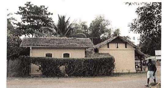
Logement de fonctionnaire à Passamaity
