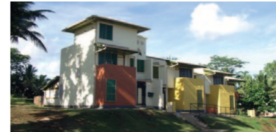
Figure 1 - Logements SIM LLI à Mroualé village de Combani, commune de Tsingoni (Mayotte).
