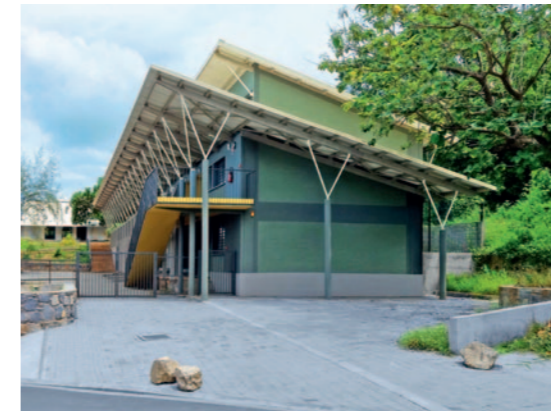
Figure 5 - École élémentaire, Nyambadao commune de Bandrélé, 2008. © DT&A architectes
