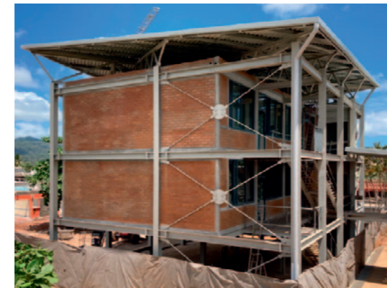
Figure 6 - Lycée de Kahani, métal et BTC, 2022. © JV03 architectes & urbanistes
