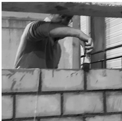
1. Humidifier le plan de pose
