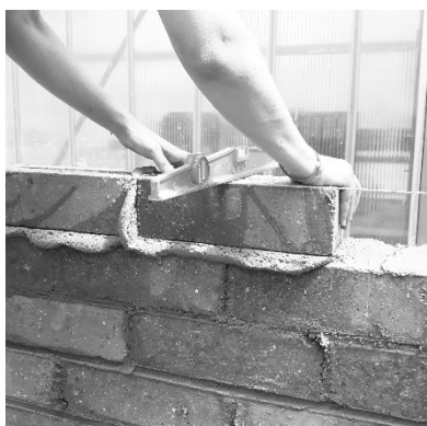
7. Contrôler l'horizontalité avec un niveau
