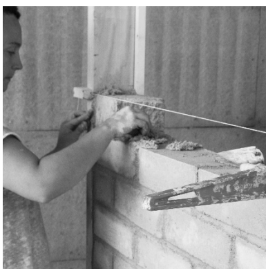
8. Contrôler l'alignement avec un cordeau
