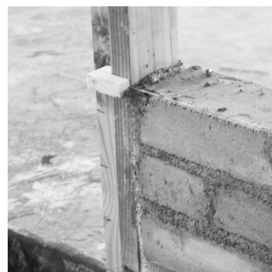
9. Contrôler l'épaisseur des joints avec une pige graduée
