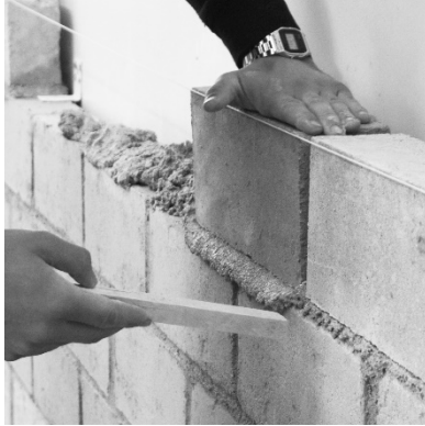
11. Retirer l'excès de mortier immédiatement
