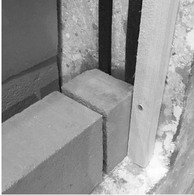
10. Contrôler la verticalité avec une pige d'angle (et/ou au fil à plomb)
