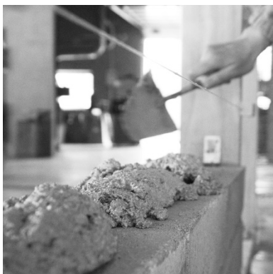
2. Disposer la juste quantité de mortier
